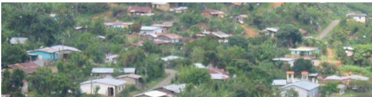
Figura 10. Zona de asentamientos humanos en zona rural
